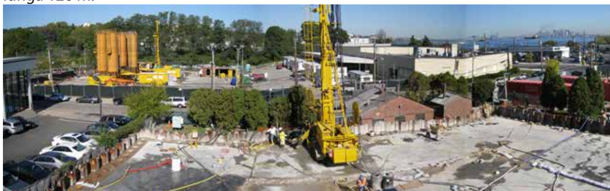
Fig. 8. Vista panoramica del cantiere
