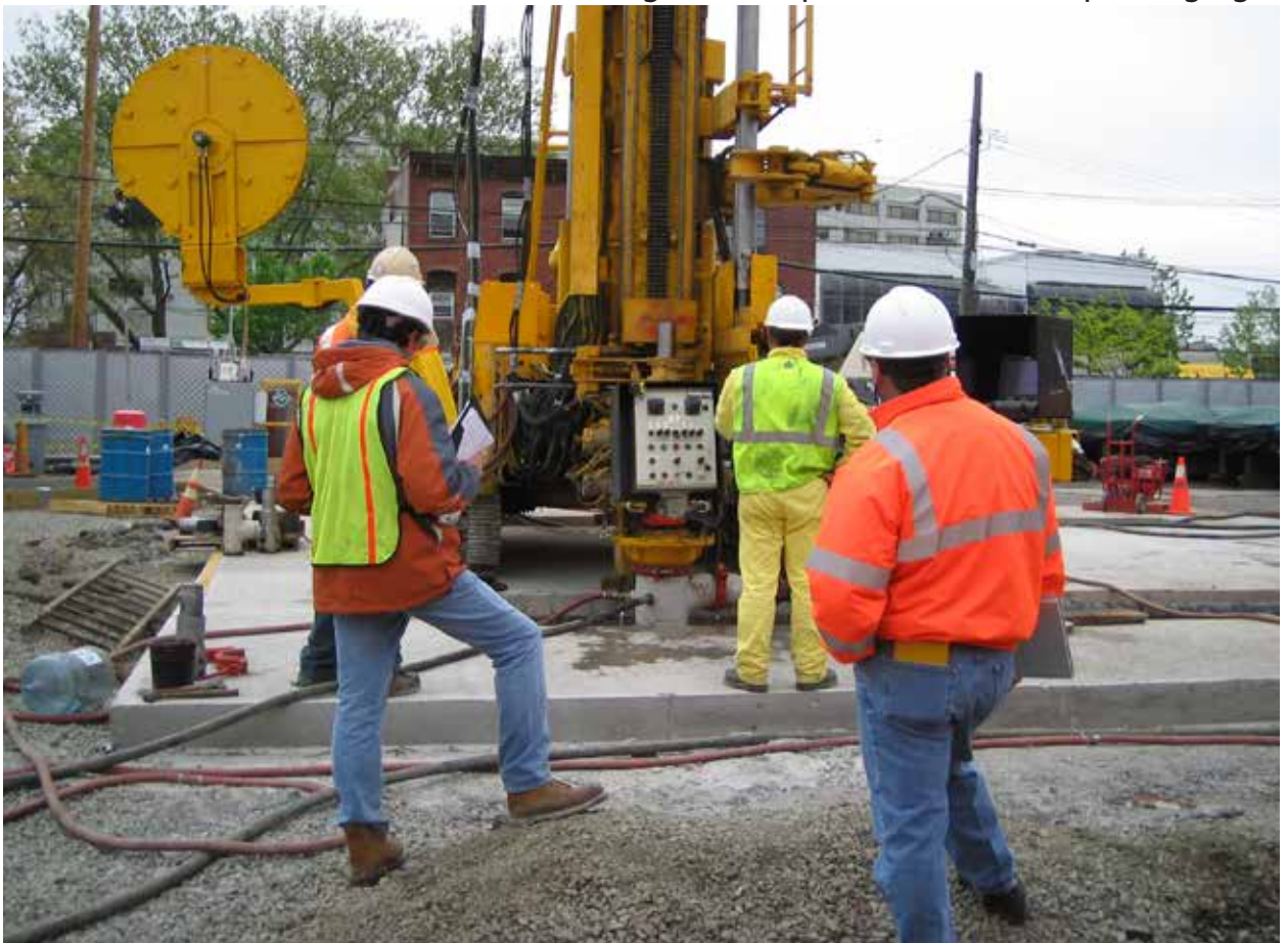
Fig. 4. Esecuzione del campo prove – Jet Grouting
