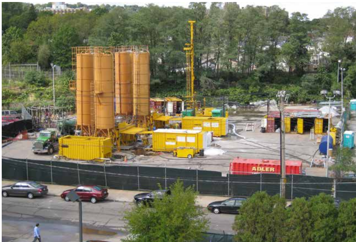
Fig. 10. Il cantiere – Installazioni fisse
