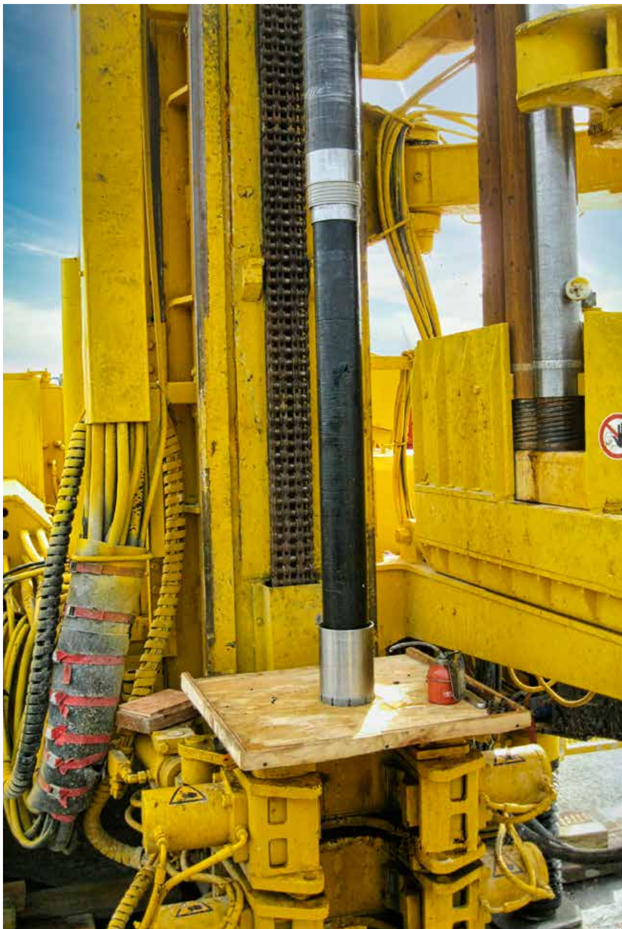
Fig. 10. Foto scattate durante l'estrazione dal carotiere di un campione di jet grouting con eccellente recupero.
