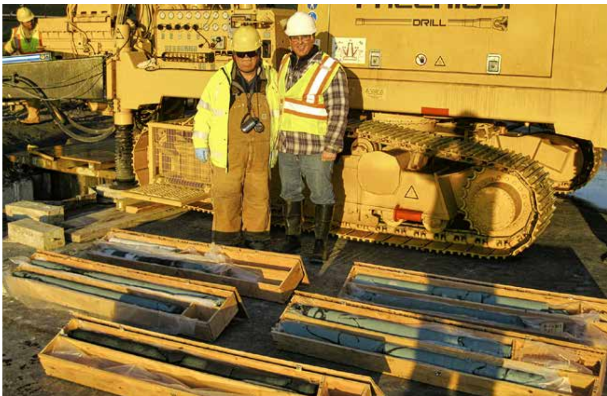
Fig. 9. Esecuzione dei carotaggi di controllo
