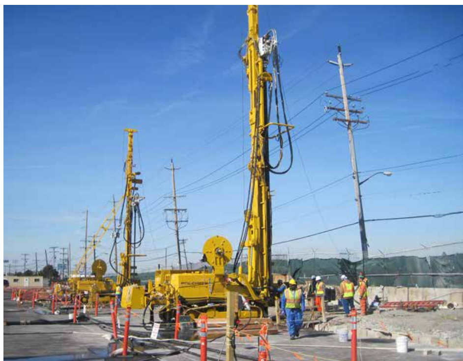
Fig. 5. Perforatrici PACCHIOSI DRILL P1500 ECS con caricatore aste automatico durante le fasi lavorative
