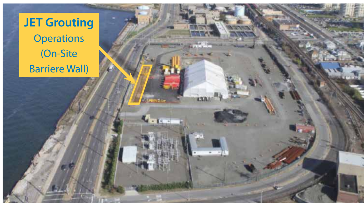
Fig. 3. Vista area dell'area di Rockaway Park MGP durante l'esecuzione dei lavori
