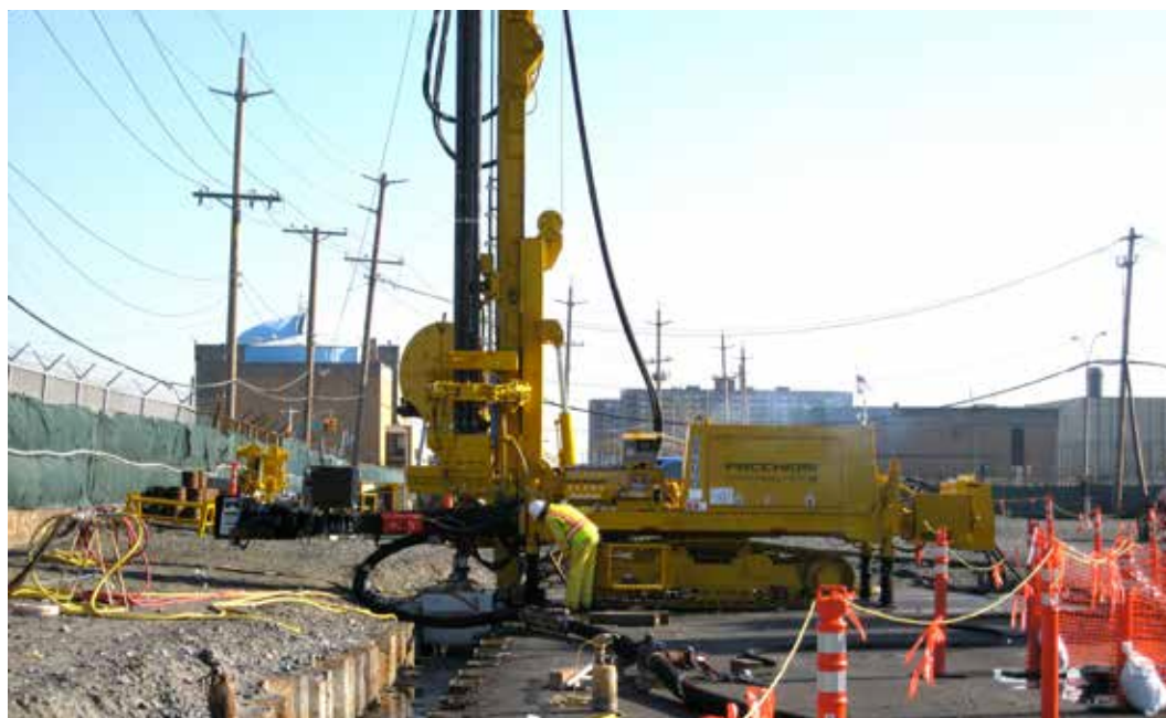
Fig. 1. Posizionamento perforatrice P1500 ECS
