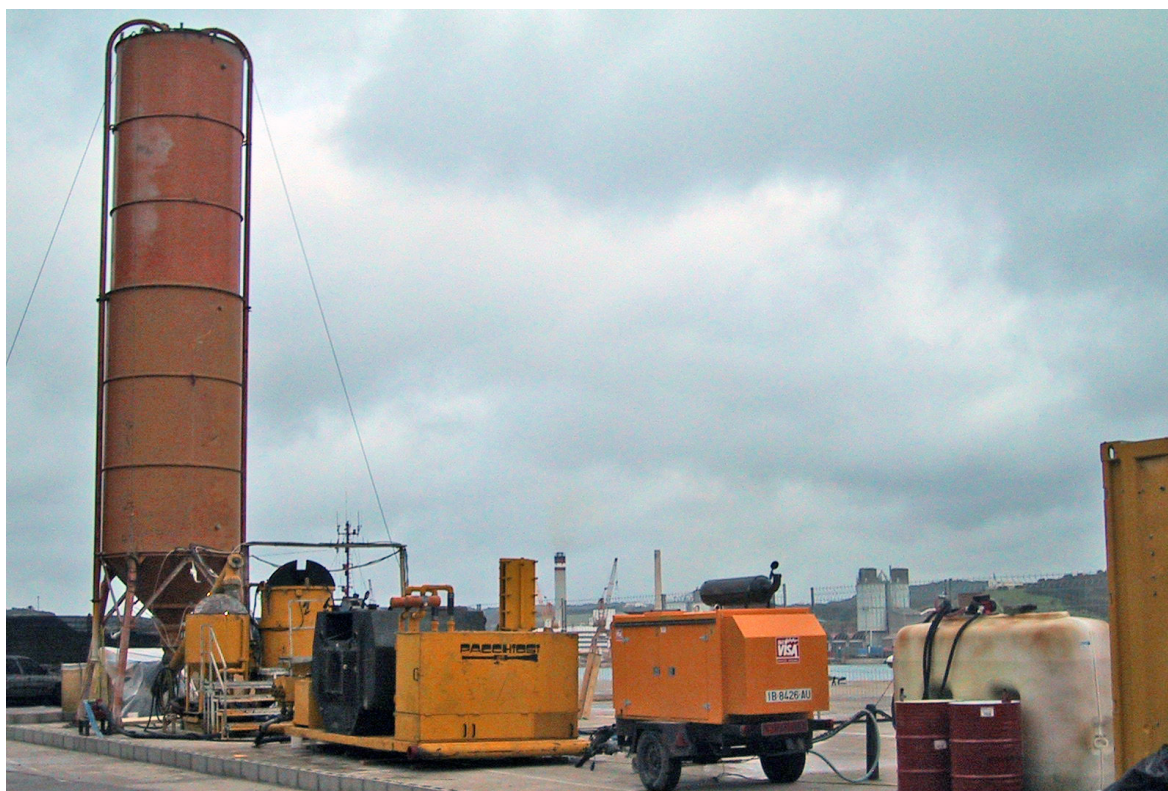
Fig. 8. Vista del cantiere.
