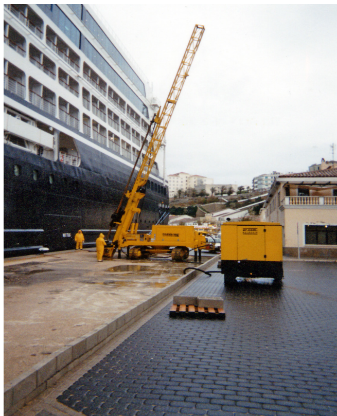
Fig. 4. Sonda P 1500 EC durante il Jet Grouting.
