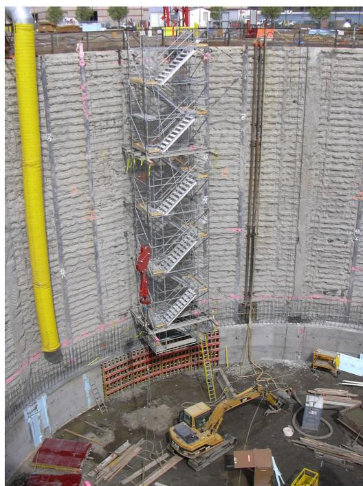
Fig. 9. Immagini dello scavo circolare del pozzo di Pump Station..
