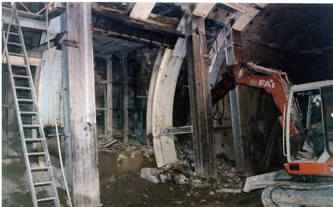
Fig. 10. Intertubo: fase di demolizione controllata dei conci del rivestimento definitivo.
