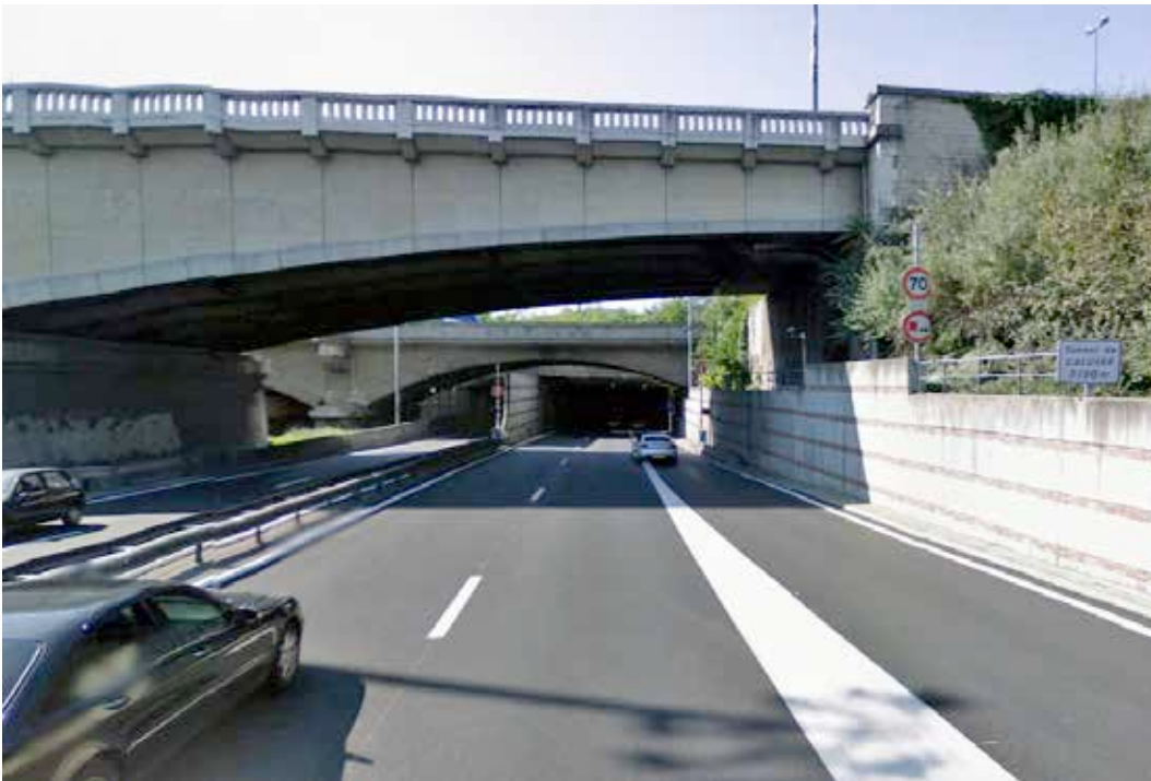
Fig. 1. Imbocco Est del tunnel a due canne.
