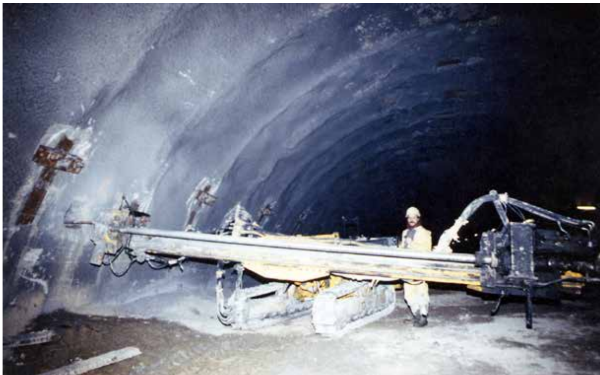
Fig. 12. Sonda PRP 105 D durante l'ancoraggio delle centine.
