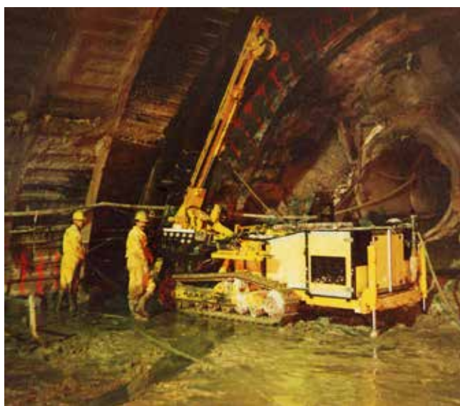
Fig. 11. Sonda PRP 105 D durante la realizzazione delle colonne armate.
