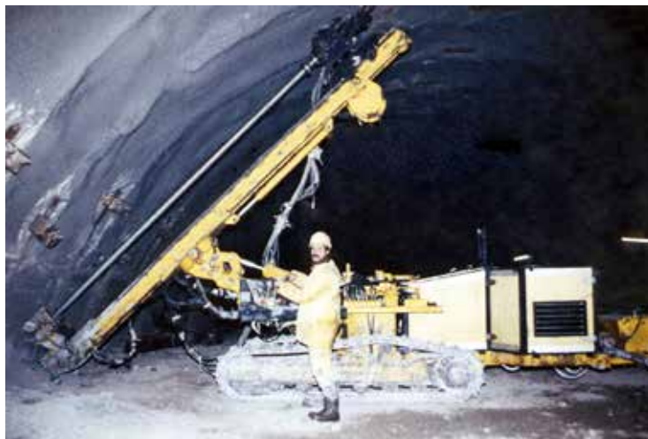
Fig. 9. Sonda PRP 105 D impegnata nel consolidamento dei piedritti.
