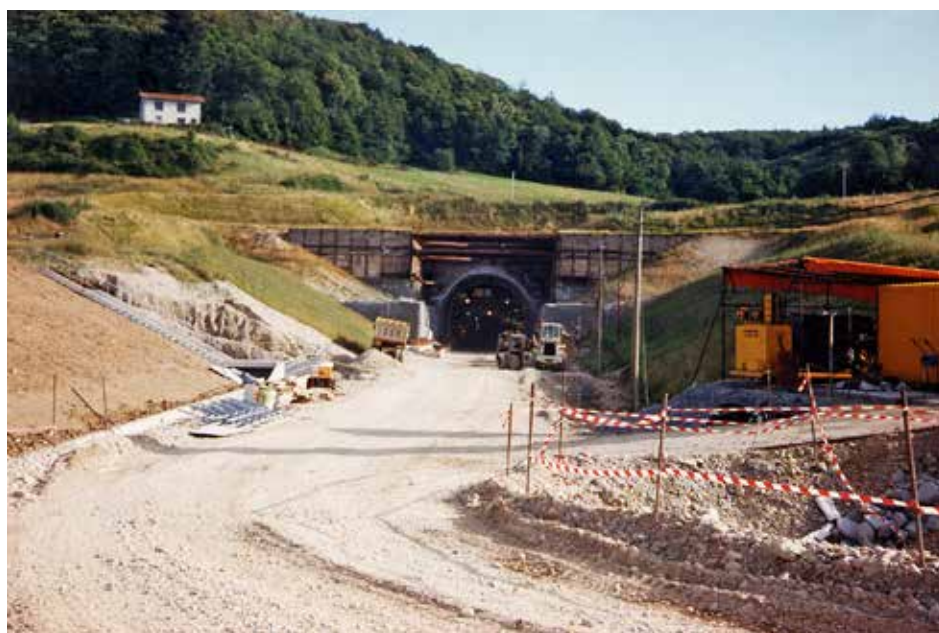
Fig. 1. Vista dell'imbocco del tunnel.
