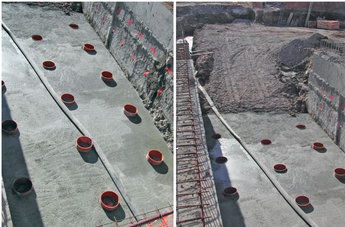
Fig. 15-16. Soletta CA con la predisposizione dei fori di attesa per l'esecuzione dei trattamenti.
