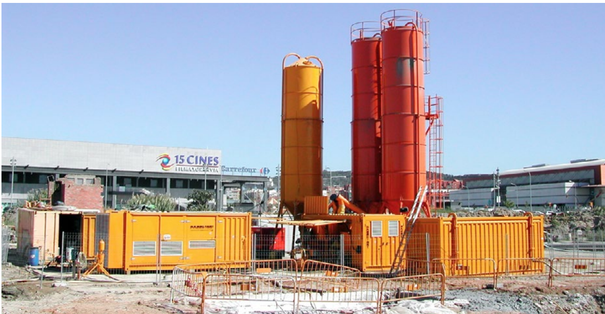
Fig. 39. Installazioni fisse di cantiere; silos di stoccaggio cemento (2) e bentonite (1), centrale di dosaggio e miscelazione componenti (mixer PACCHIOSI MA 2000) e pompa (PACCHIOSI LASER 2800) per acqua e miscele cementizie; containers per officina e magazzino.
