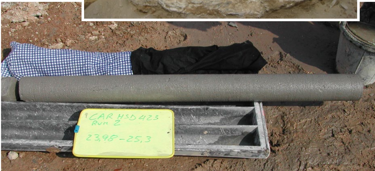
Fig. 25. Esempio di carotaggio; si noti la perfetta omogeneità e continuità del trattamento eseguito.
