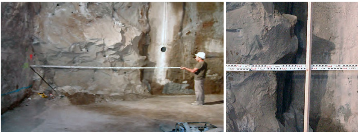
Fig. 10-11-12. Misurazione di una colonna di chiusura tra diaframmi ortogonali.
