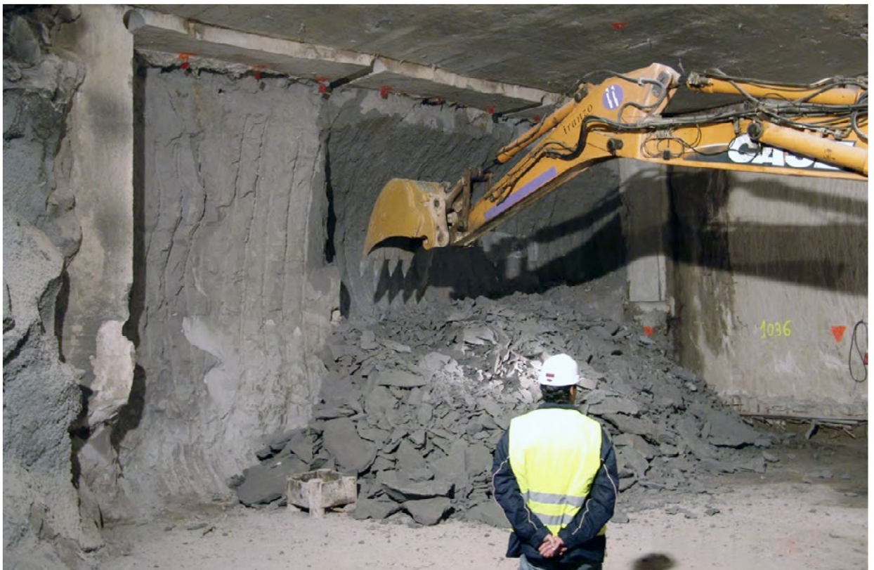
Fig. 13-14. Fasi di scavo nella massa di terreno consolidato con il metodo MEGA JET GROUTING PS3.
