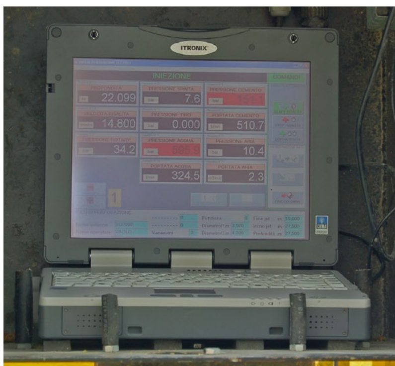
Fig. 27. Computer installato sulla perforatrice; visualizzazione a monitor dei parametri caratteristici.
