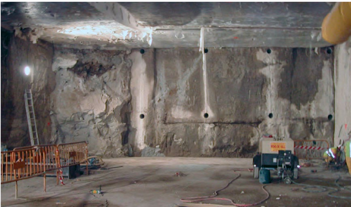
Fig. 9. Particolare di una colonna di chiusura tra diaframmi ortogonali; planimetria.
