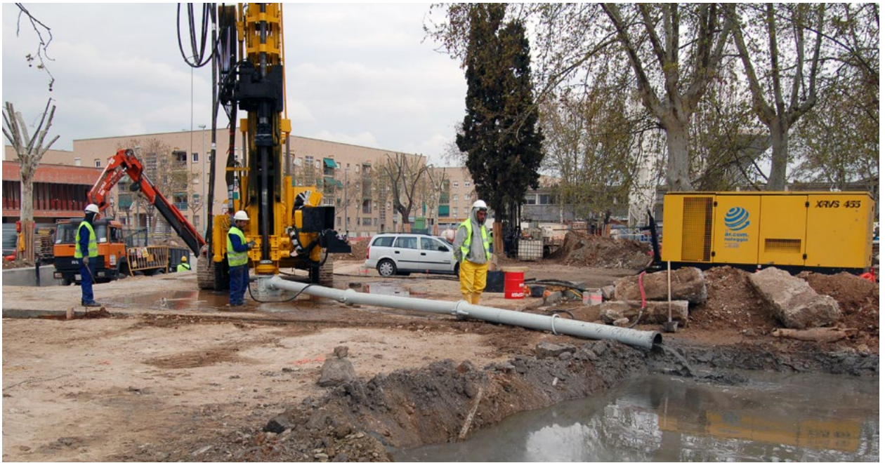
Fig. 31. Recupero dei reflui di perforazione/iniezione e convogliamento in vasca di decantazione.
