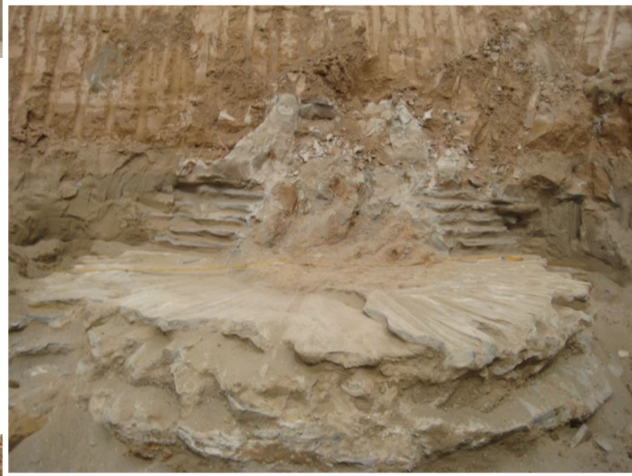
Fig. 23-24. Particolare colonna scoperta, diametro \varnothing oltre 5 m.
