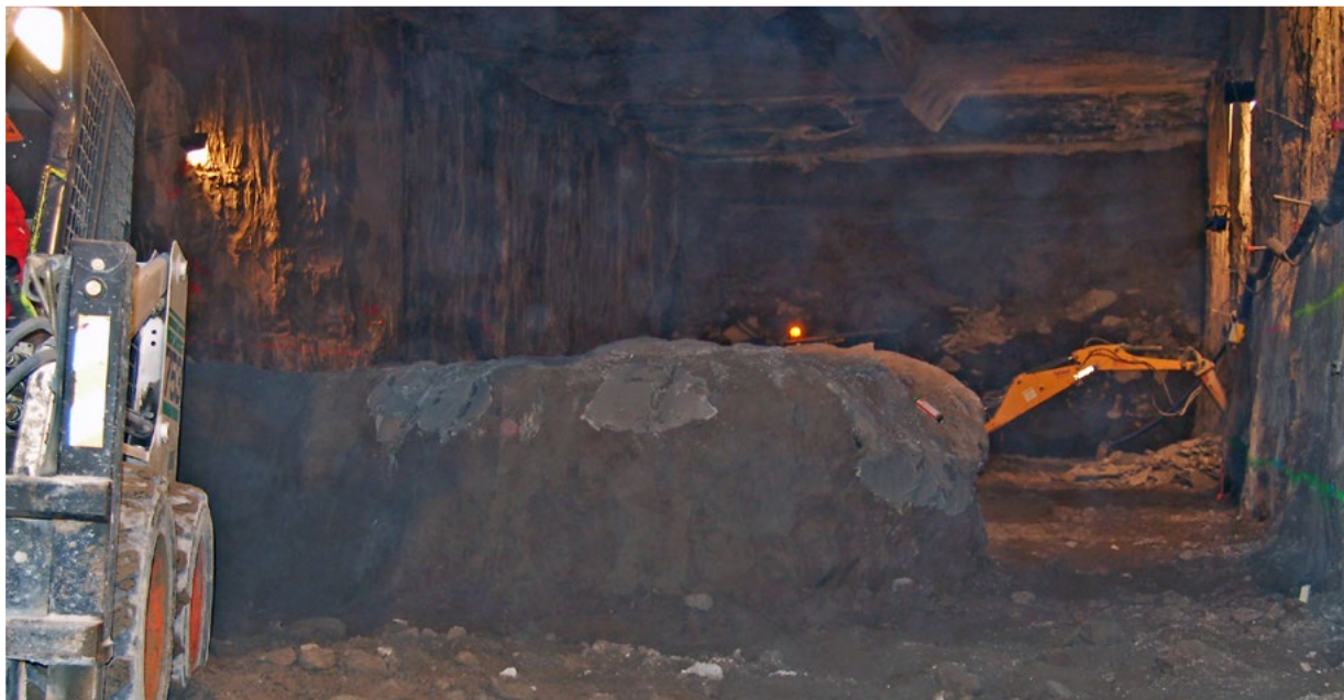
Fig. 18. Sommità di una colonna scoperta e misurata direttamente; diametro \varnothing oltre 4 m.
