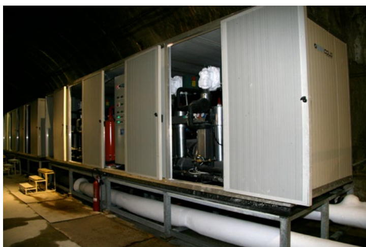
Fig. 7. Containerizable compressors (8 units).
