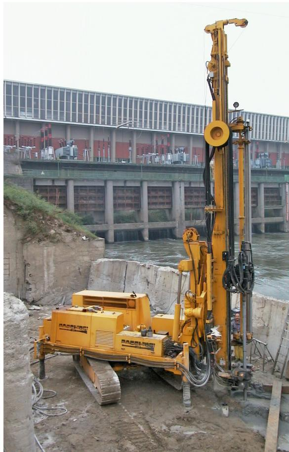
L'esecuzione di ogni colonna è stata preceduta dal carotaggio della struttura in cemento armato del cassone.
