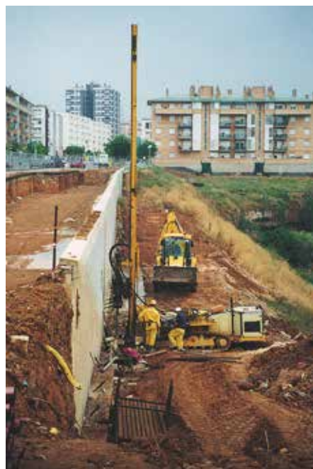
Fig. 8. PRP 105 durante il consolidamento delle fondazioni.
