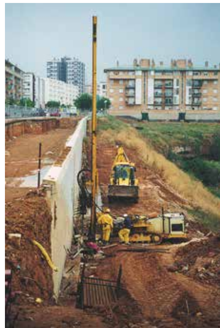
Fig. 7. PRP 105 durante il consolidamento delle fondazioni.
