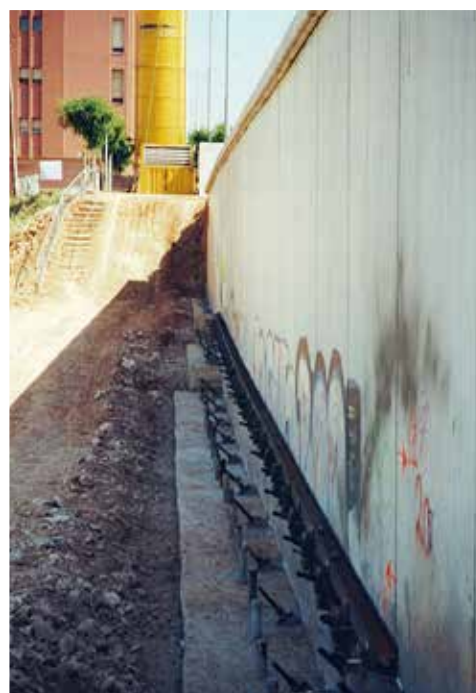
Fig. 9. Particolare delle travi di ripartizione.
