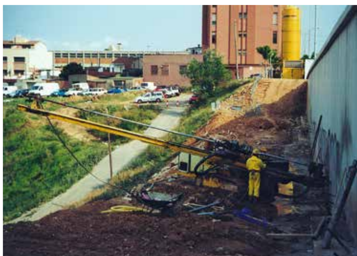
Fig. 8. PRP 105 durante il consolidamento dei pannelli del muro.
