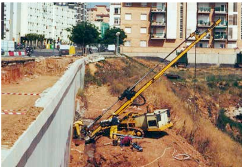
Fig. 5. Sonda PRP 105 durante l'ancoraggio alla trave di fondazione.
