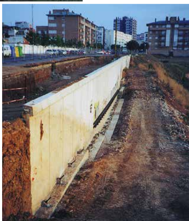
Fig. 2. Vista del muro consolidato.
