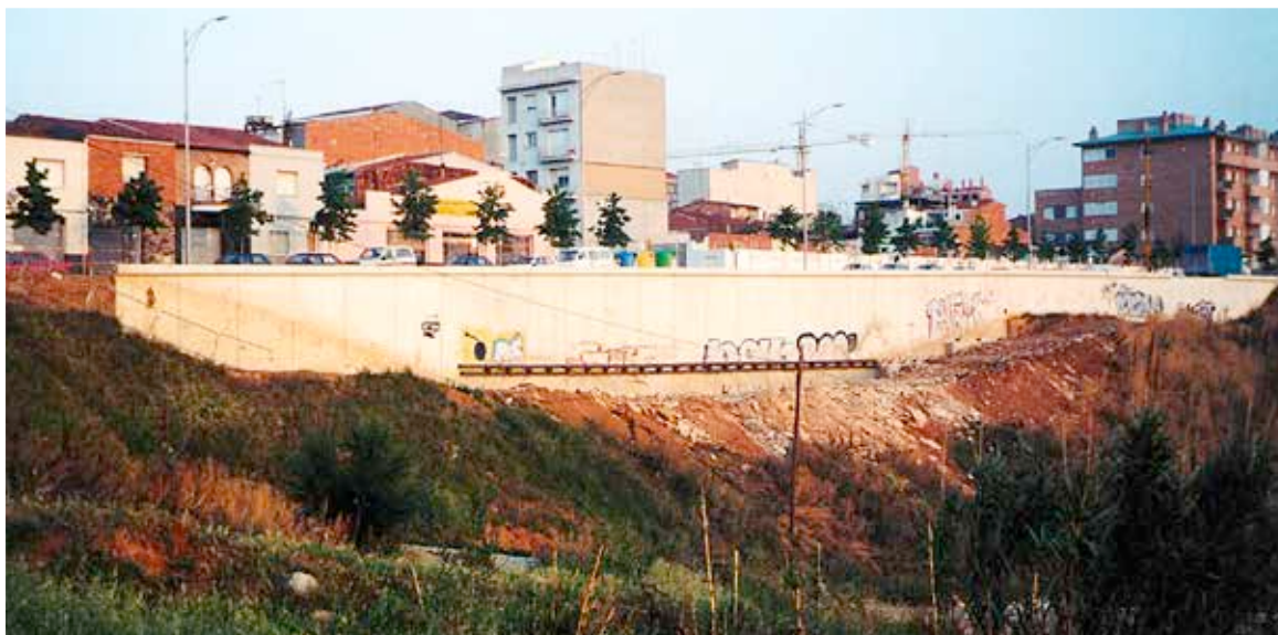
Fig. 10. Vista del muro consolidato.
