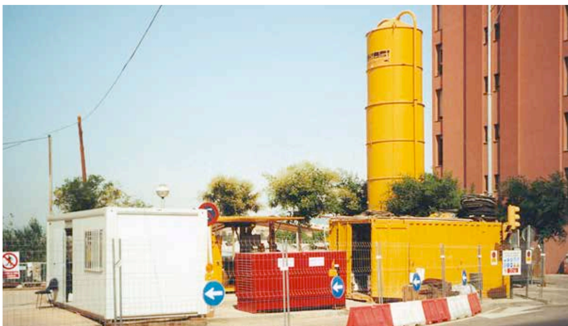
Fig. 11. Vista del cantiere.
