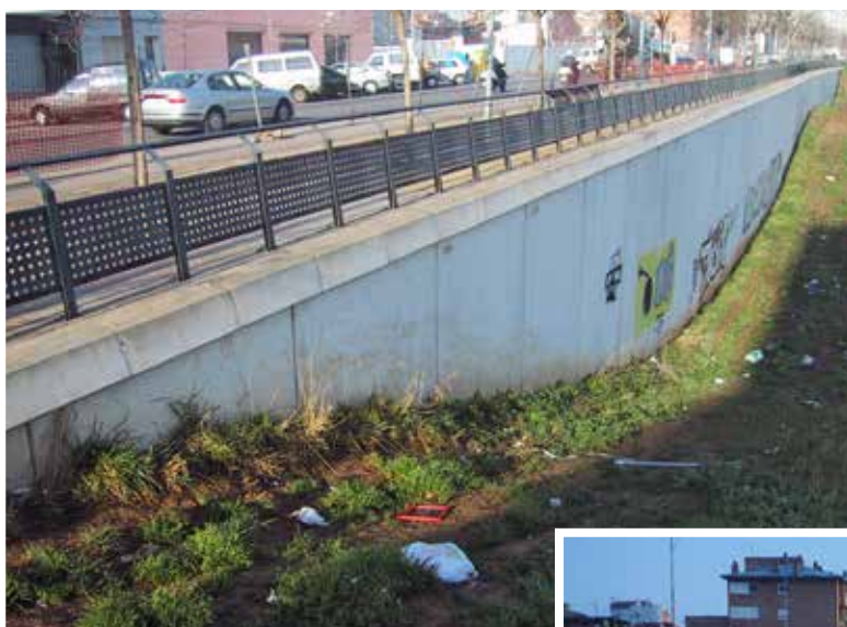
Fig. 1. Vista del muro prima dell'intervento.
