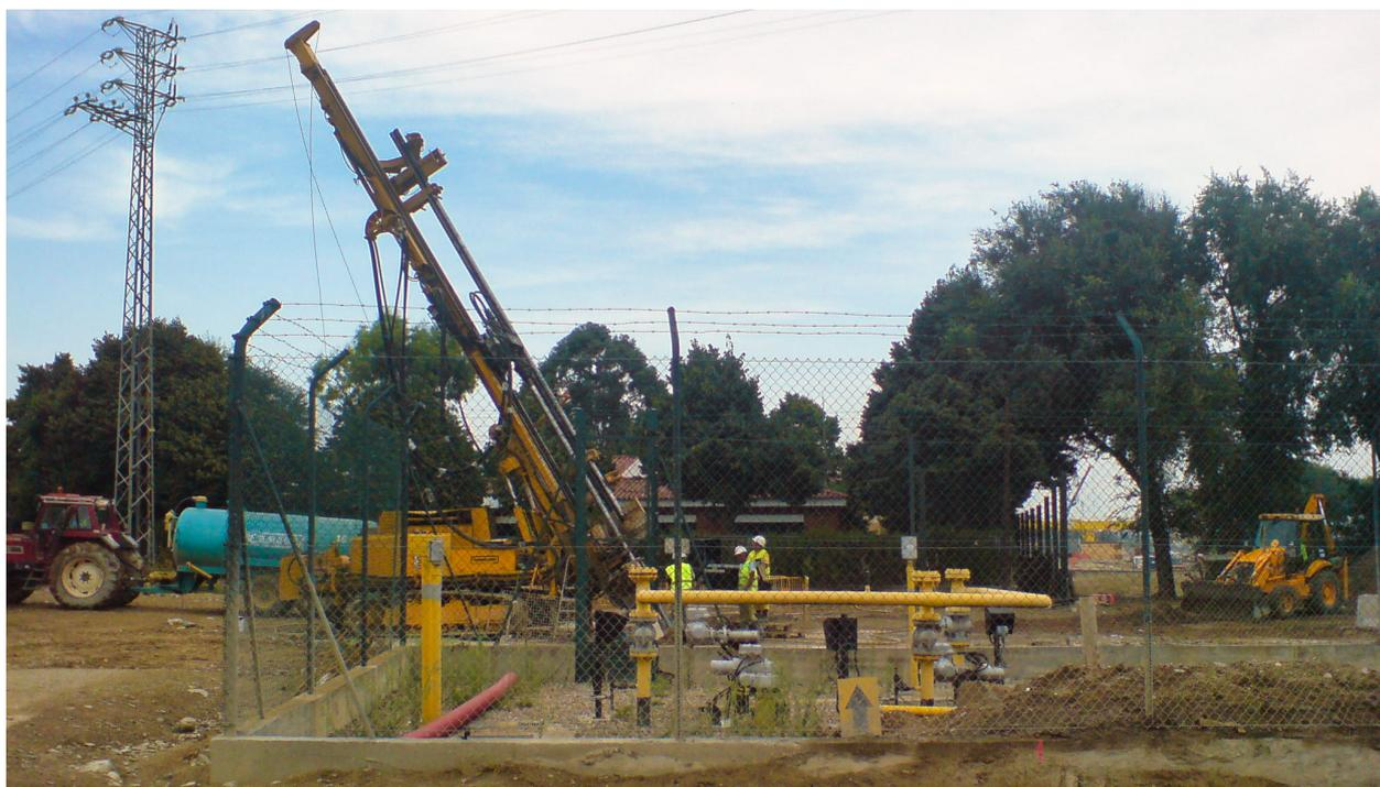
Fig. 7. Foto scattate durante l'esecuzione delle colonne inclinate al lato della caseta gas
