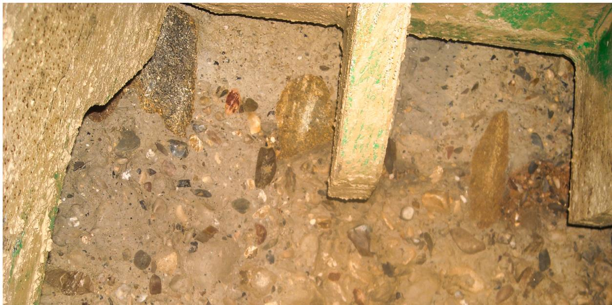
Fig. 6. Foto scattate all'interno della testa fresante della TBM-EPB – in evidenza la consistenza del trattamento jet grouting.
