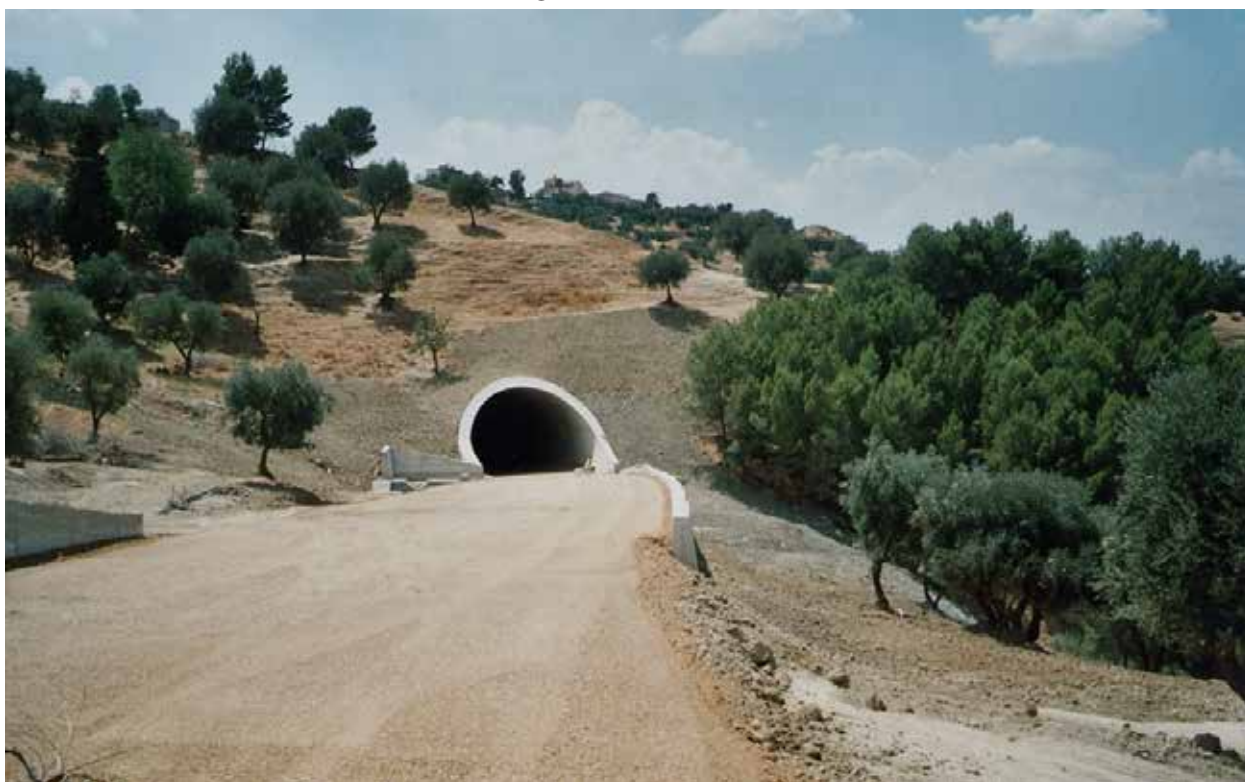
Fig. 21. Sbocco di monte della galleria.
