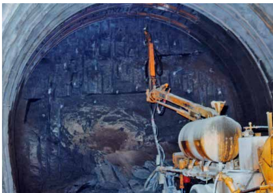
Fig. 14. Spritz - beton.
