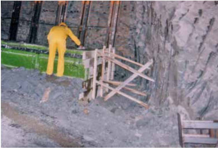
Fig. 7. Posa centine, piedritti e murette.
