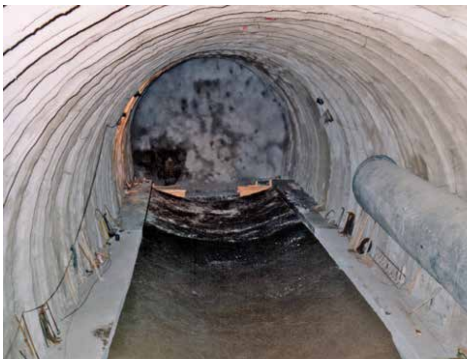
Fig. 16. Vista della galleria pre-rivestita.
