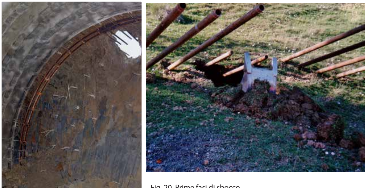
Fig. 20. Prime fasi di sbocco.
