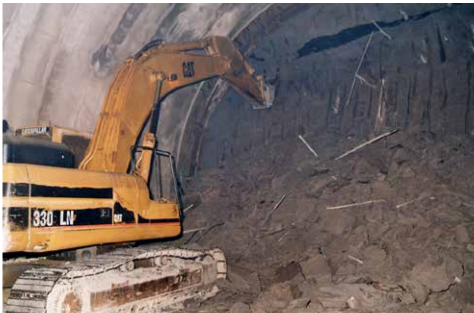
Fig. 12. Fase di scavo.
