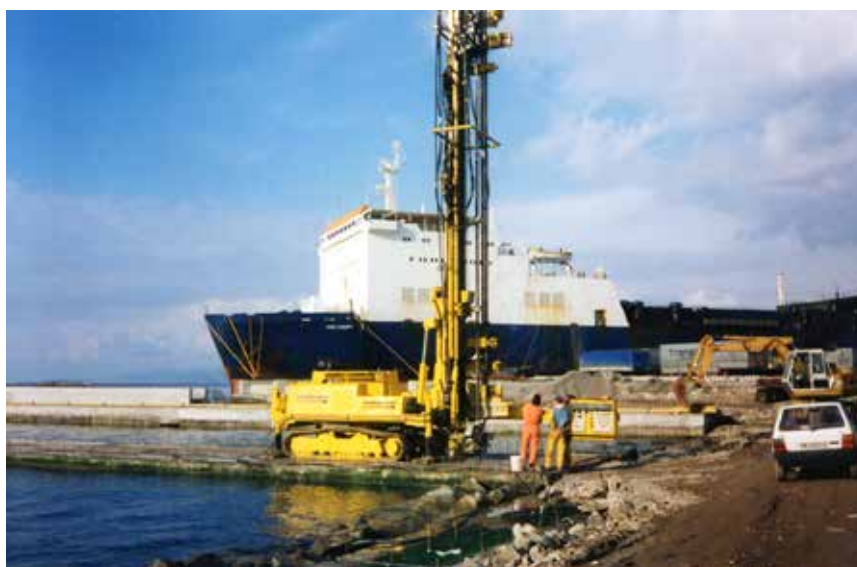
Fig. 12. P 1500 ECS drill rig.
