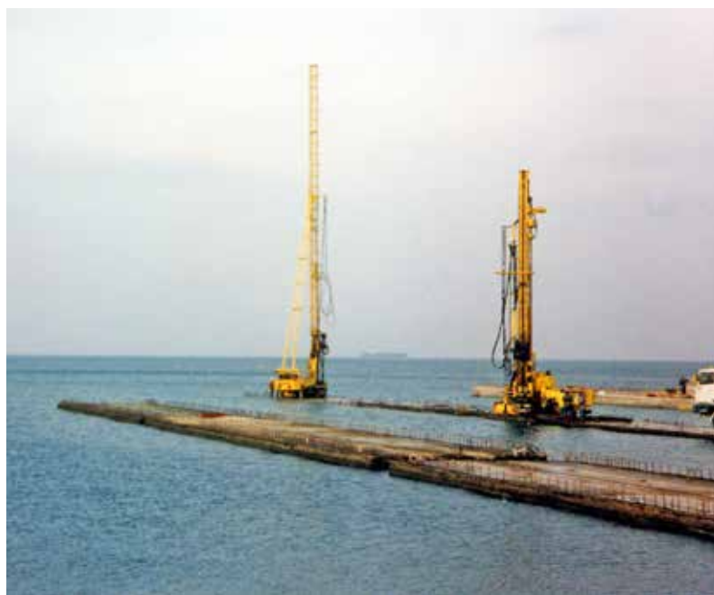
Fig. 7. Sonde P 1500 EC e P 1500 ECS durante l'esecuzione dei lavori.
