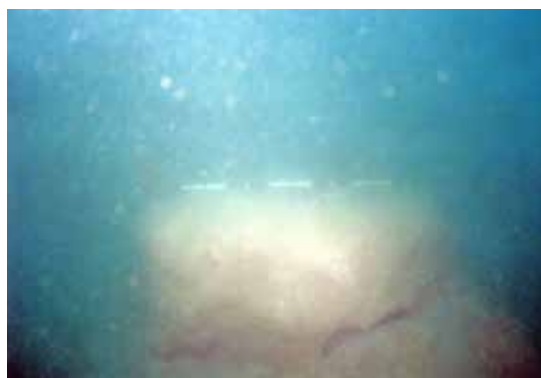
Fig. 3. Colonna Jet Grouting in veduta subacquea.
