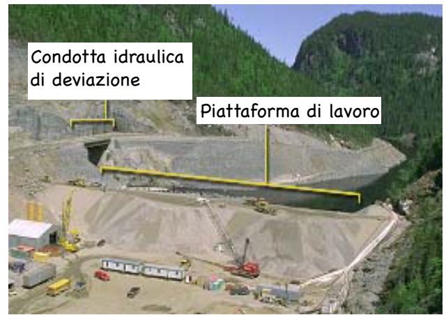
Fig. 6. Rappresentazione del cantiere.
