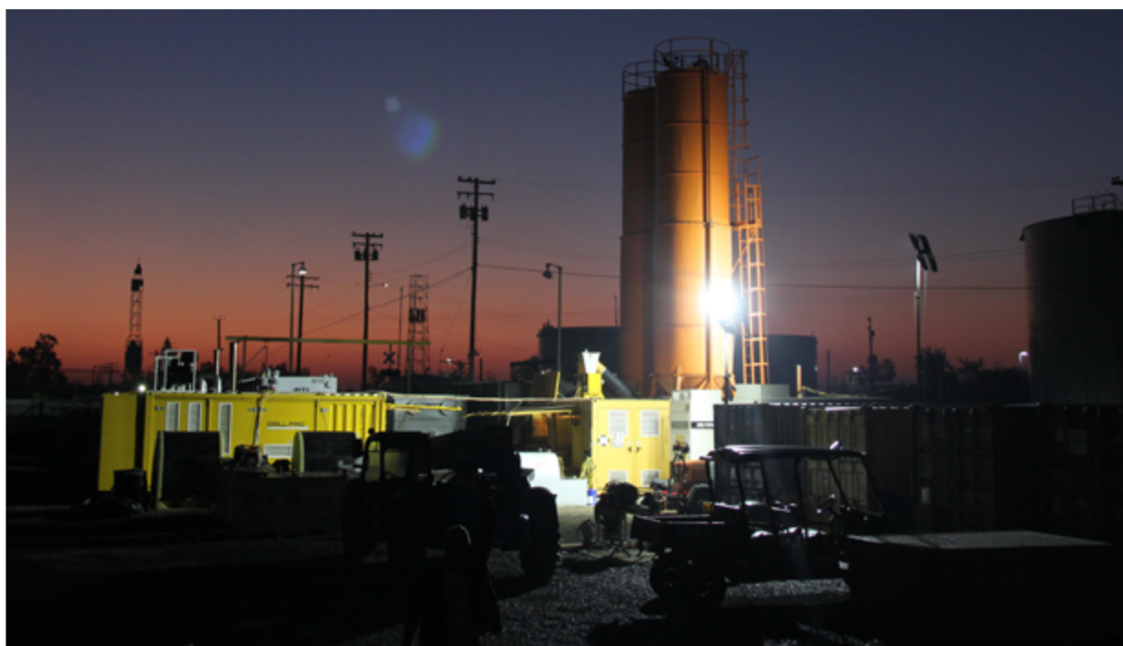
Fig. 22 - Installazione di cantiere
