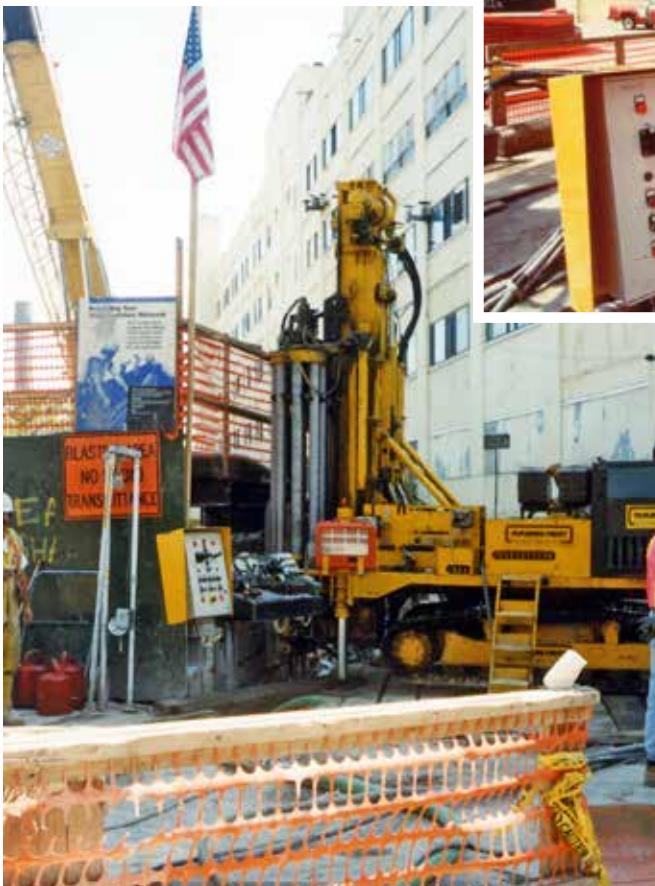
Fig. 9. Sonda P 1000 impegnata durante le fasi di Jet-Grouting.
