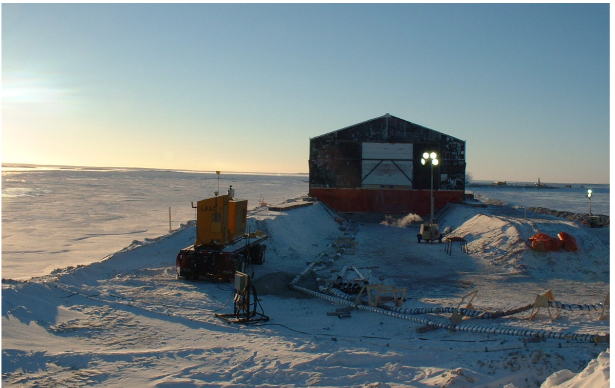
Fig. 7. Immagine dell'impianto coperto realizzato per la protezione degli impianti di miscelazione e pompaggio.
