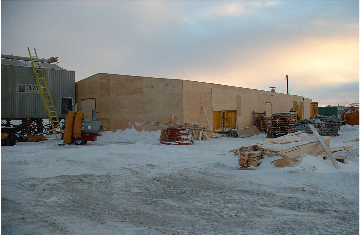
Fig. 7. Immagine dell'impianto coperto realizzato per la protezione degli impianti di miscelazione e pompaggio.
