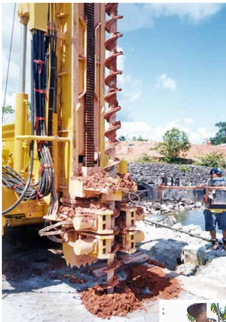
Fig. 11. Perforazione con l'utilizzo di aste elicoidali per la posa dei tubi in pvc.
