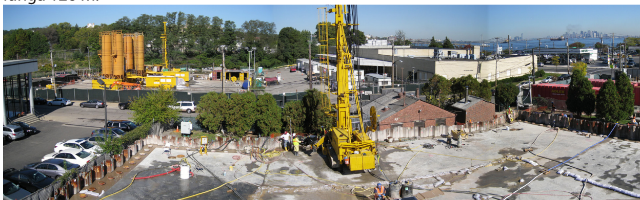
Fig. 8. Vista panoramica del cantiere
