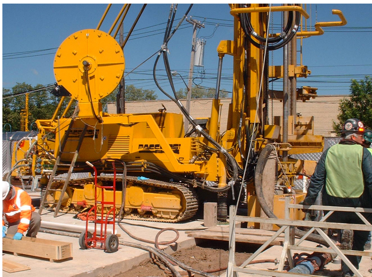
Fig. 5. Esecuzione del campo prove – Carotaggi di controllo
