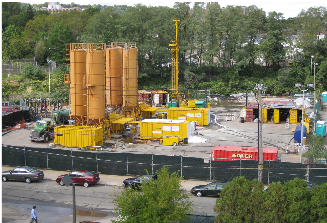
Fig. 10. Il cantiere – Installazioni fisse
