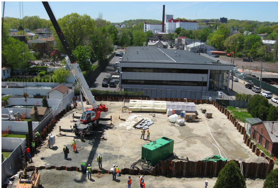
Fig. 2. Palancole metallica perimetrale
