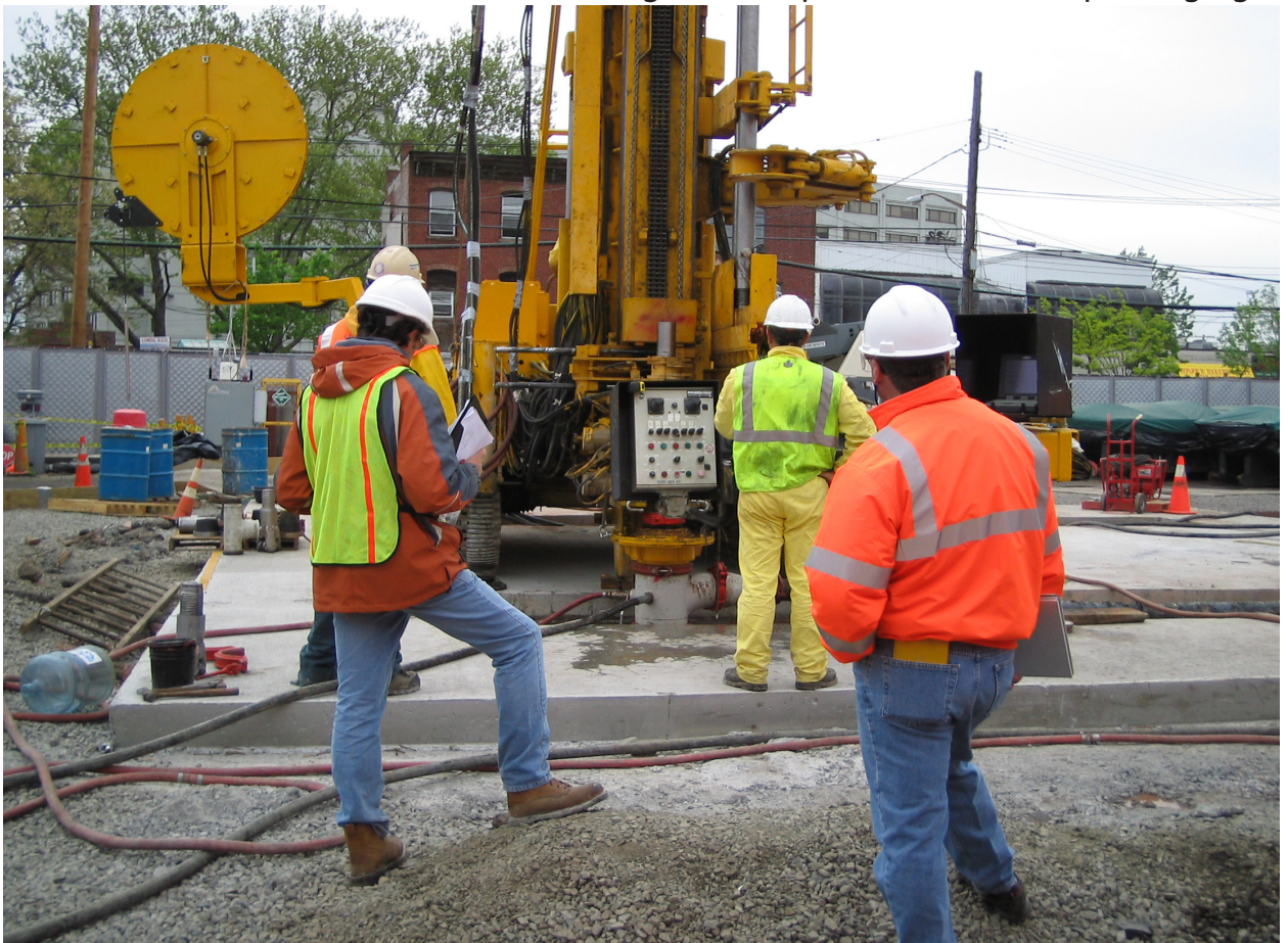
Fig. 4. Esecuzione del campo prove – Jet Grouting
