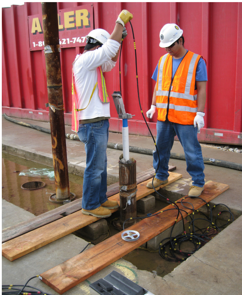
Fig. 13. Ispezione visiva con telecamera all'interno dei carotaggi
