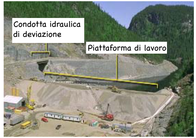
Fig. 6. Rappresentazione del cantiere.
